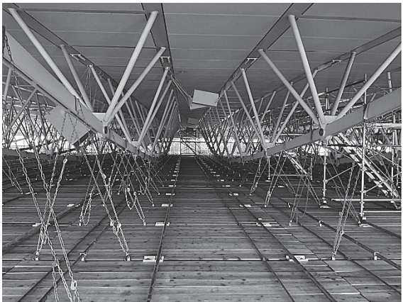
天井部分 足場掛状況
