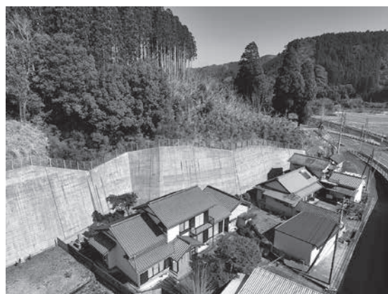
宮ノ下地区（佐伯市）：急傾斜地崩壊対策事業
