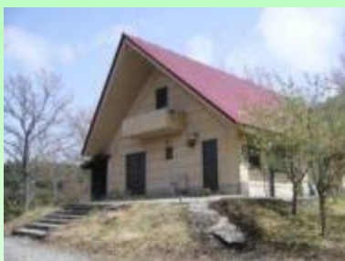
管理棟（事務室・用具倉庫）
