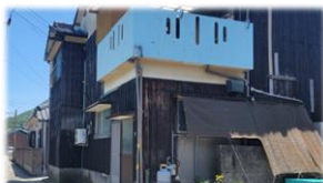
使用“烧杉板”的房屋
