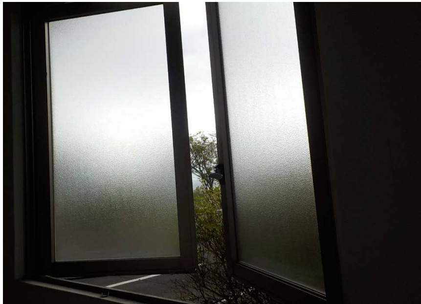
<機動隊庁舎1階 更衣室開き窓鍵>
