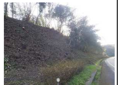
【大分空港道路支障木伐採】
