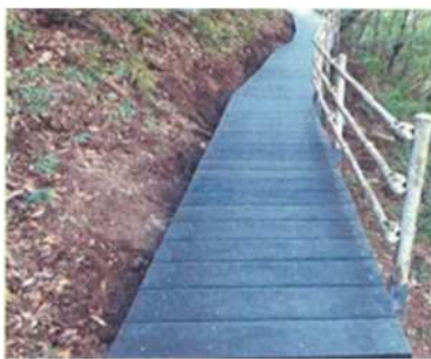
【藤河内溪谷遊歩道整備】
