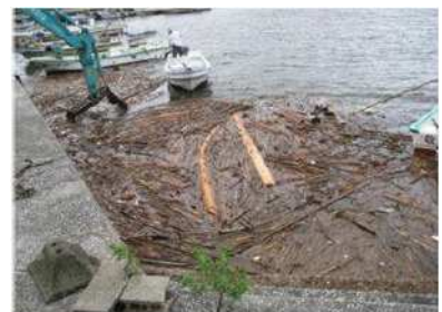
【港の流木等回収・撤去】
