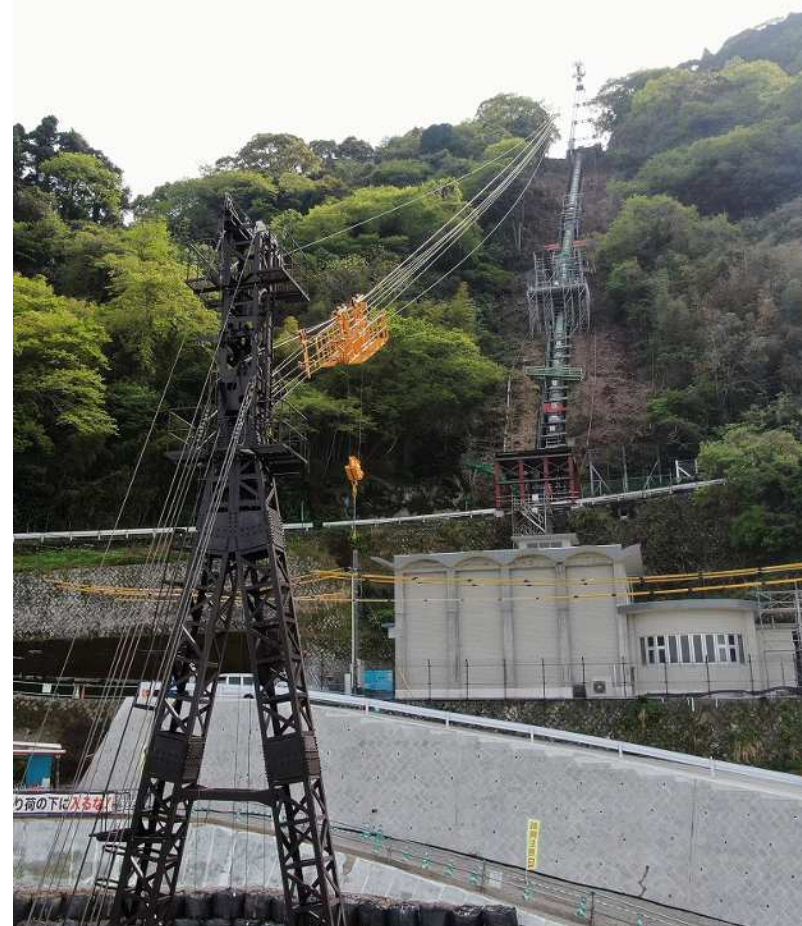
別府発電所 水圧鉄管据付中
