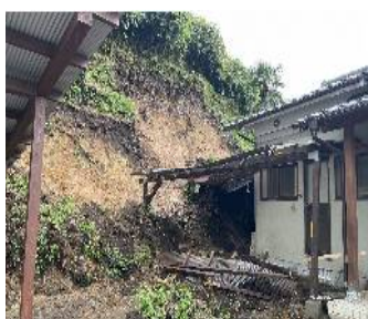
R6台風10号によるがけ崩れ 国分地区(大分市)
