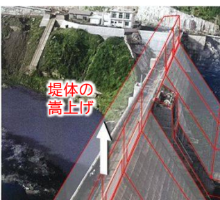
嵩上げによる洪水調節機能の強化 安岐ダム(国東市 S46竣工)
