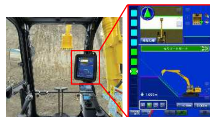
ICT建設機械による施工
