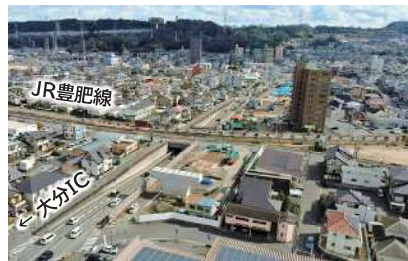
庄の原佐野線（下郡工区）整備状況
