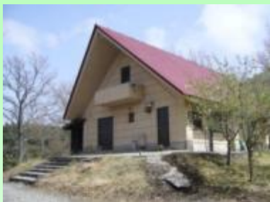
管理棟（事務室・用具倉庫）
