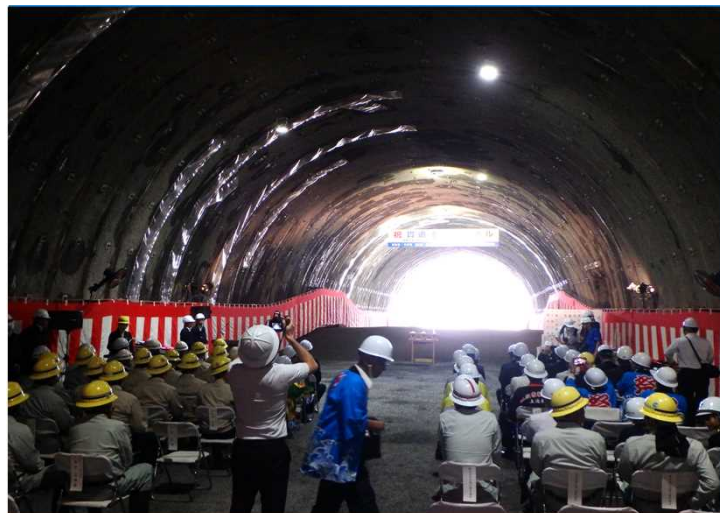
無事、トンネルは貫通しました
