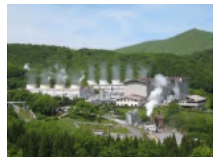
九州電力(株)八丁原発電所
