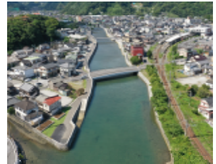
河川改修が完了した津久見川
