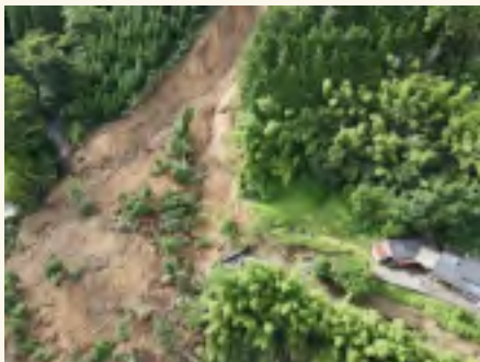
ドローンによる被災箇所調査
