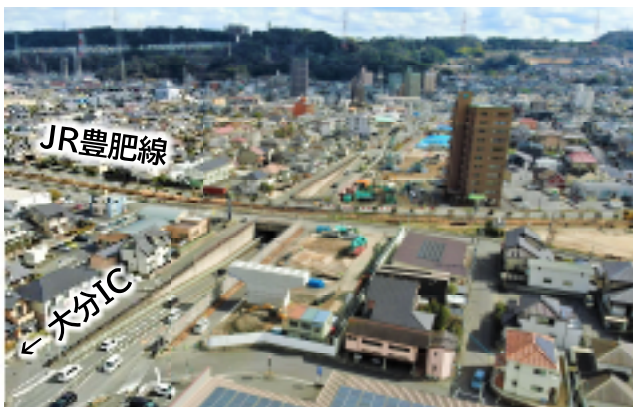
庄の原佐野線（下郡工区）整備状況
