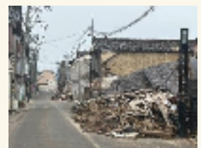
能登半島地震による被害状況
