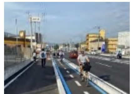
自転車通行空間の整備状況 (国道442号・大分市)
