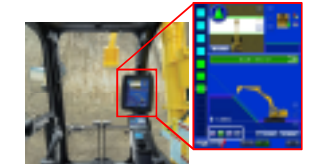
建設分野におけるICT建設機械による施工
