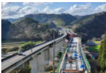
4車線化が進む東九州自動車道（宇佐IC～院内IC） （香下大橋）
