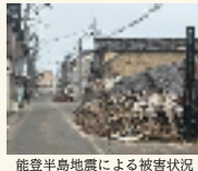
能登半島地震による被害状況
