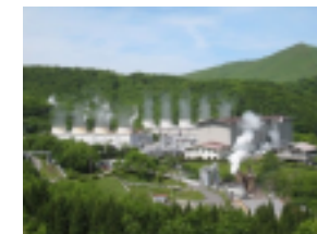
九州電力(株)八丁原発電所
