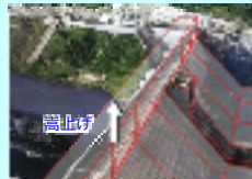
安岐ダムの再生
