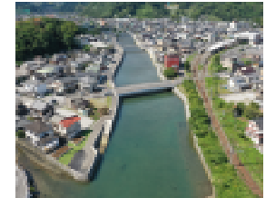
河川改修が完了した津久見川
