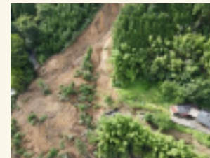
ドローンによる被災箇所調査
