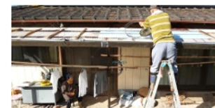
住民参加型福祉サービスによる屋根の補修
