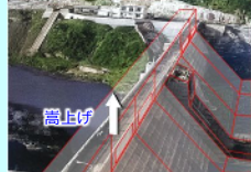
安岐ダムの再生
