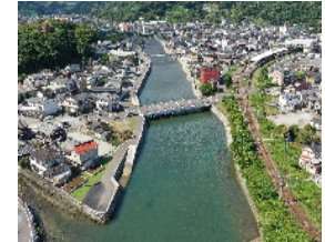
河川改修が完了した津久見川
