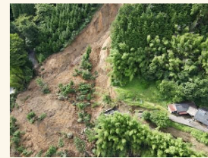
ドローンによる被災箇所調査
