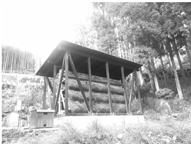
温泉の蒸気を利用した ENOWA の調理施設 (!) Cooking facility using hot spring steam at ENOWA (1)
