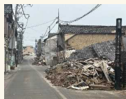
能登半島地震による被害状況
