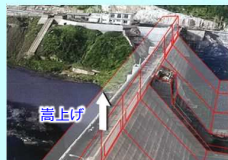
高上げ 安岐ダムの再生
