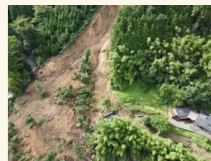
ドローンによる被災箇所調査
