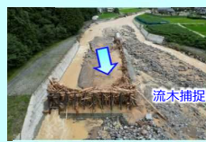
流木捕捉 小野川 (日田市) の流木捕捉 (R5梅雨前線豪雨)
