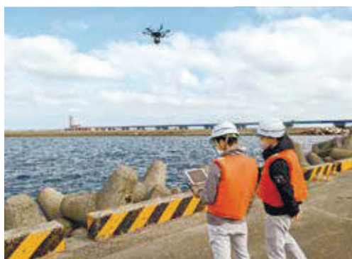
ドローンによる施設の調査
