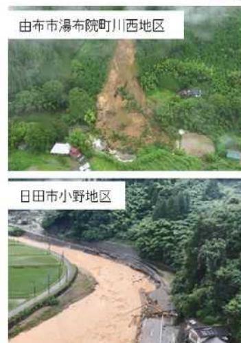
令和5年梅雨前線による大雨被災写真(由布市・日田市)
