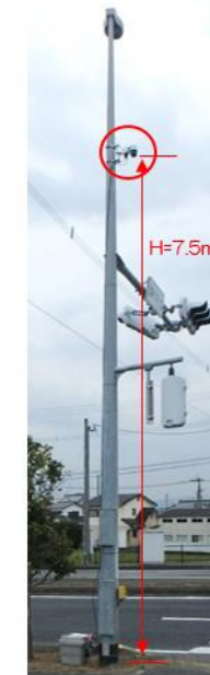
▲カメラ設置状況
