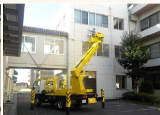
高所作業車での点検
