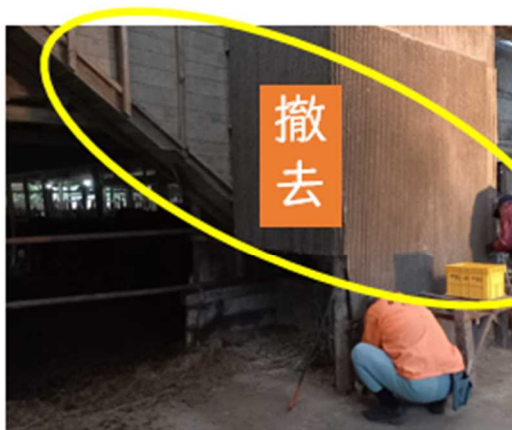
図10 作業性の改善(改善前)
