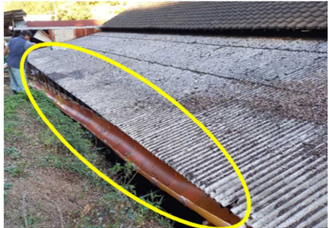
図9 雨樋の改修(改修後)
