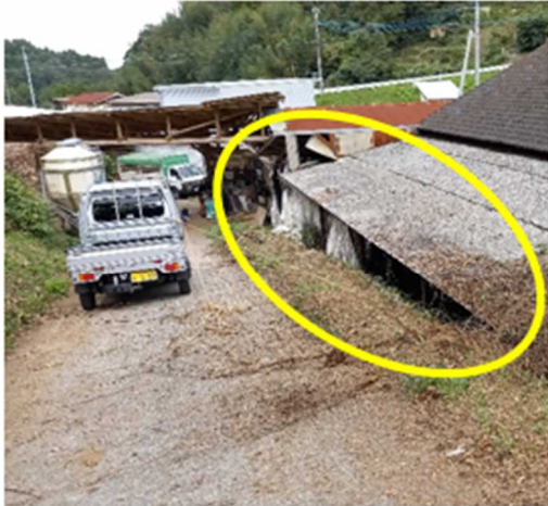
図8 雨樋の改修(改修前)
