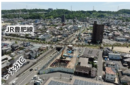
庄の原佐野線（下郡工区）整備状況
