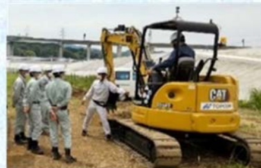
ICT建設機械による施工
