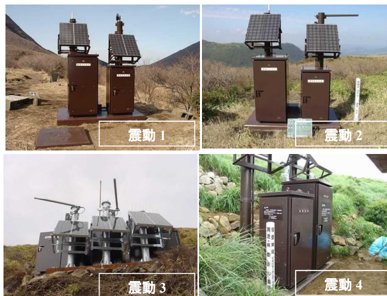
図 3.18 震動計設置状況（「平成 15 年度火噴委第 1-2 設計委託業務報告書」より引用）
