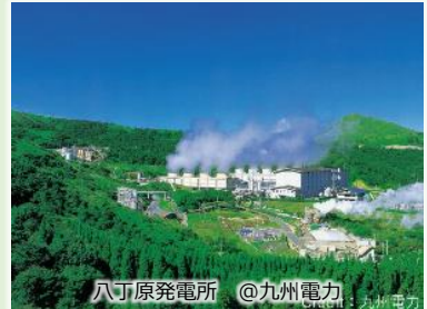
八丁原発電所 @九州電力
