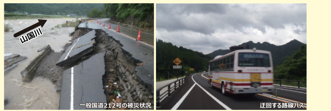
平成24年九州北部豪雨により山国川が氾濫し、一般国道212号で路面が冠水、路肩が崩壊した。耶馬溪町戸原では、38日間にわたり全面通行止めが発生したが、本耶馬溪耶馬溪道路が代替路として活躍した。
