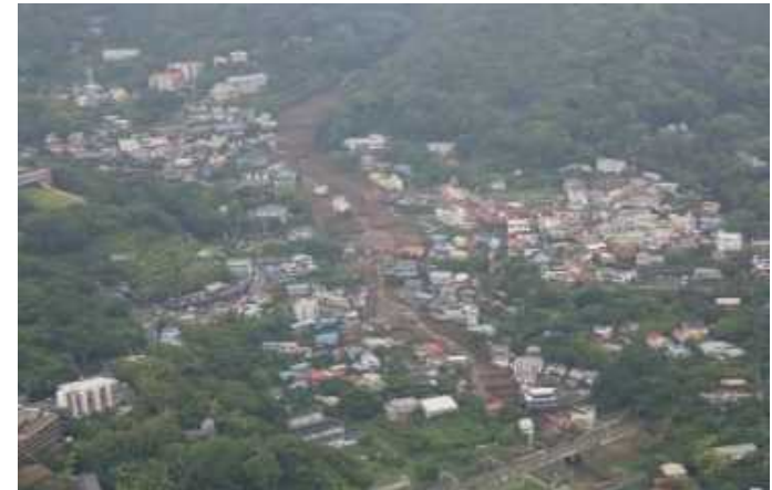
R3.7 熱海市伊豆山地区の被害状況
