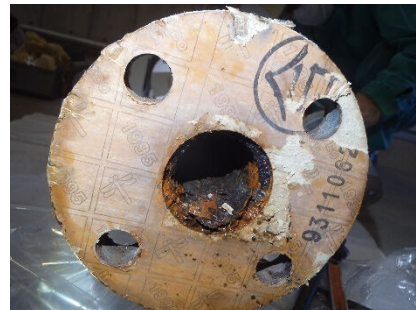
排水配管内面屋外側 (矢視②)
