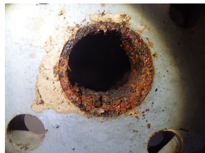
逆止弁内面屋外側 (矢視④)
