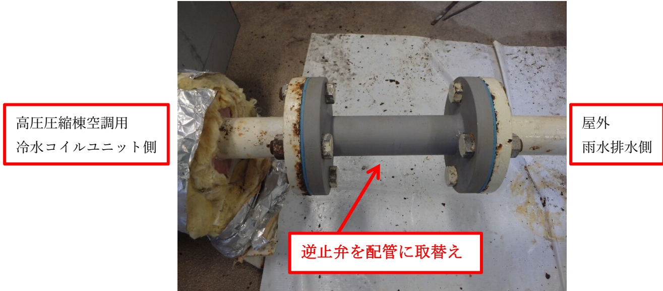
結露水排水系統の逆止弁撤去の状況
