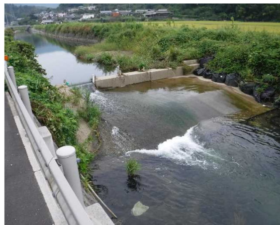
写真 1.3.2 熊崎川 堀田取水堰
