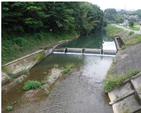
写真 1.3.1 熊崎川 中溝取水堰
