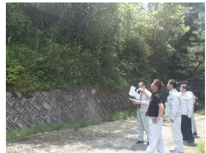
急傾斜地の点検実施状況
