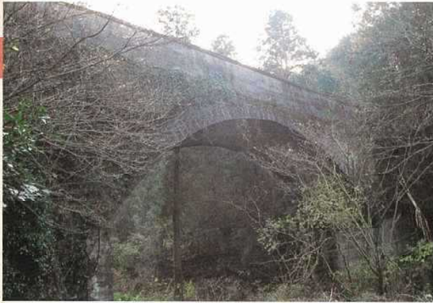
弓舟水路橋 橋長：L=51.9m
