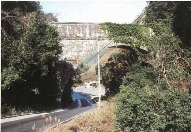
大谷川水路橋 橋長：L=42.7m
