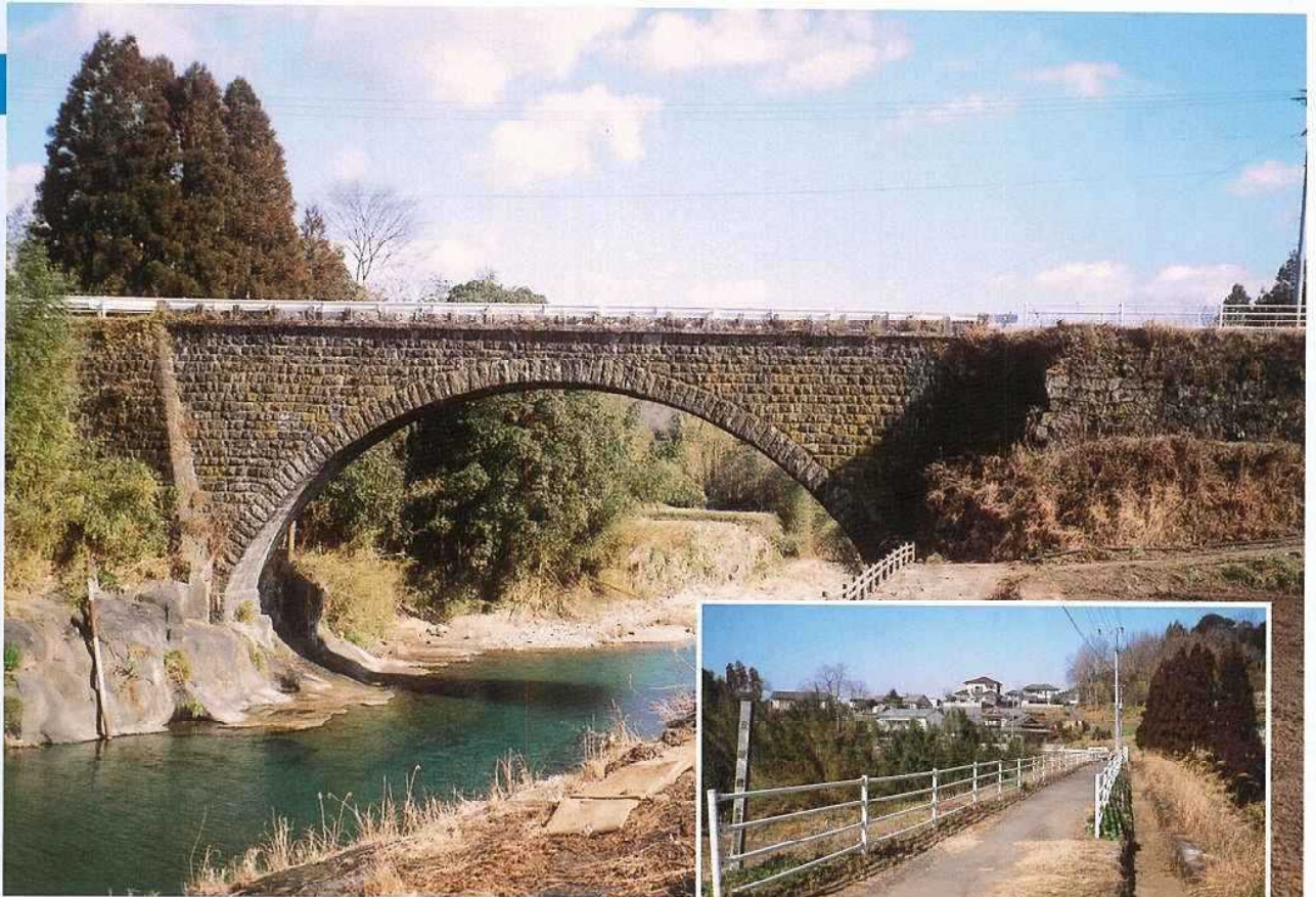
【諸元】 橋長:29.3m 橋幅:3.2m
