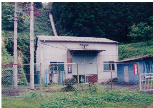
富士緒井路第一発電所（富士緒井路土地改良区） 最大使用流量=2.0(m 3 /s) 有効落差=25.50(m) 最大発電出力=380(kW) 運転開始年：1914年
