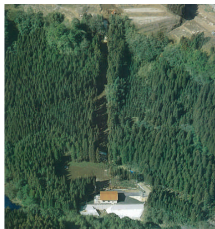
長谷緒井路発電所（長谷緒土地改良区） 最大使用流量=1.0(m 3 /s) 有効落差=179.22(m) 最大発電出力=1,300(kW) 運転開始年：1991年
