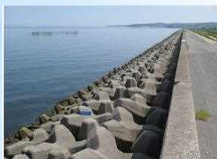
消波ブロックの設置
