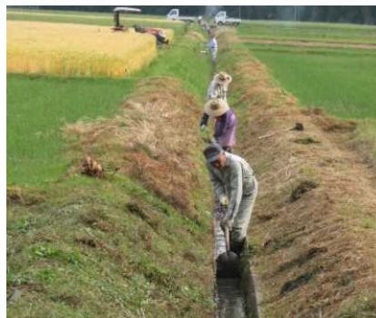
水路の泥上げ
