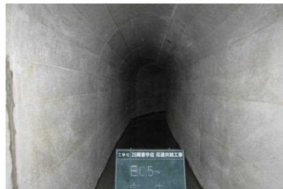
コンクリート覆工した水路トンネル
