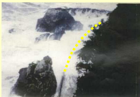
古江丸市尾線越波状況
