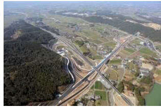
○東九州自動車道(豊前～宇佐間:H27.3開通) ○中津日田道路(東九州道～中津港直結:H27.3開通)
