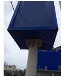
支柱・広告板接合部
