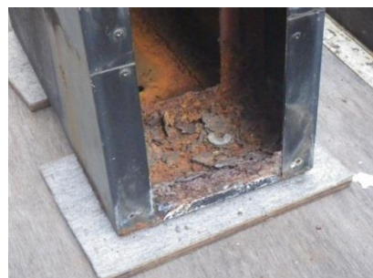
底部が腐食していた看板の例
