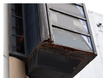
側板底面が腐食、破損した状態
