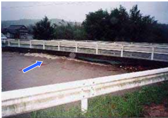
写真 2-1 平成 9 年 9 月 出水 の 状 況 [ 大 川 橋 付 近 : 三 光 村 大 字 西 秣 付 近 ]
