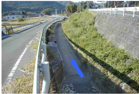
写真 2-4 山国川荒瀬井堰 からの導水路 [ 三光村大字臼木付近 ] (平成 15 年 10 月撮影)
