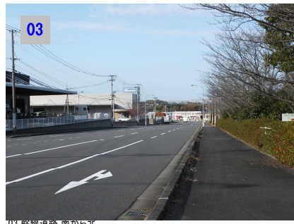
03 幹線道路 南から北
