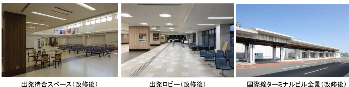
図5 国際線ターミナルビルの増改築
