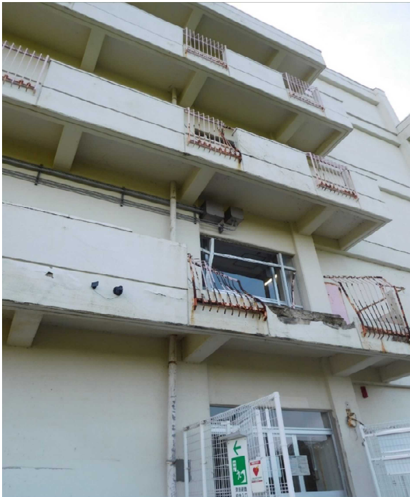
★ 荒浜小学校の校舎
