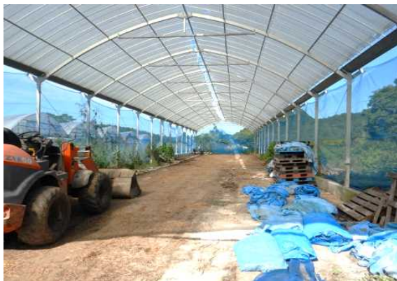
写真9 ハウス①改善後のハウス内部
