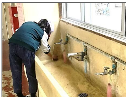
NO.472 2021年11月 津久見市立津久見小学校
