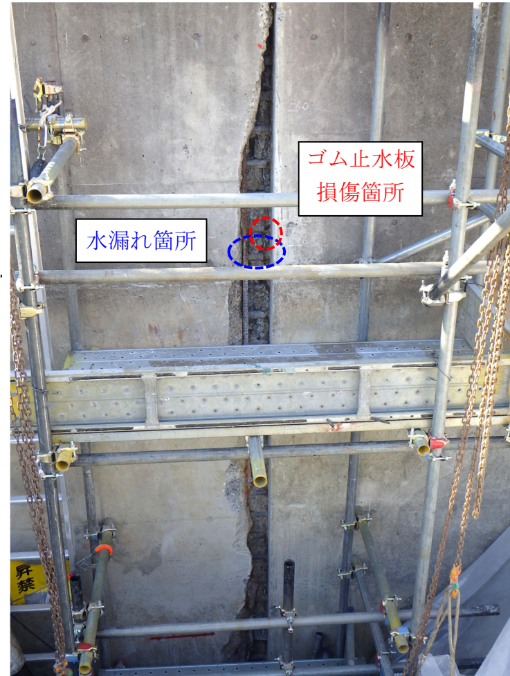
ひび割れ部のコンクリート撤去状況
