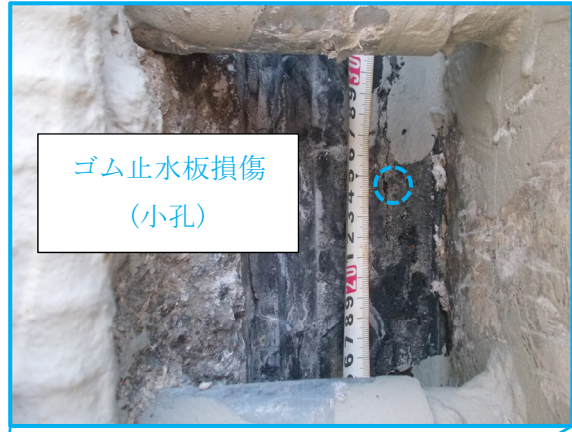
ゴム止水板の損傷
