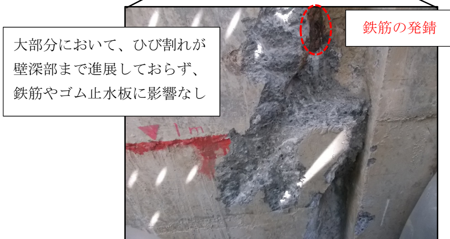
地中部のひび割れ部のコンクリート撤去
