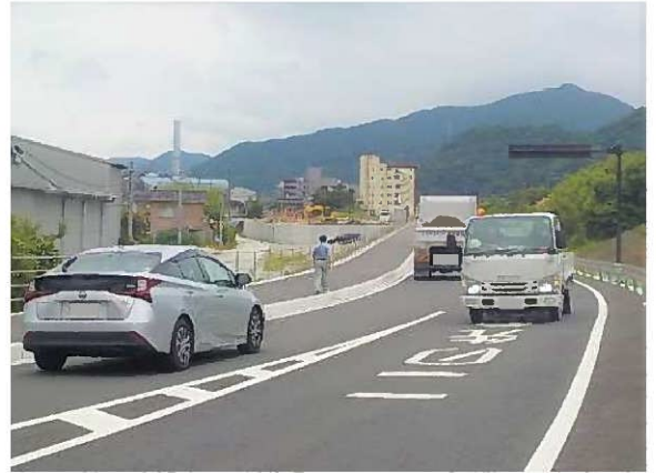
▲ 国道217号 (平岩松崎バイパス) 津久見市大字上青江～ セメント町
