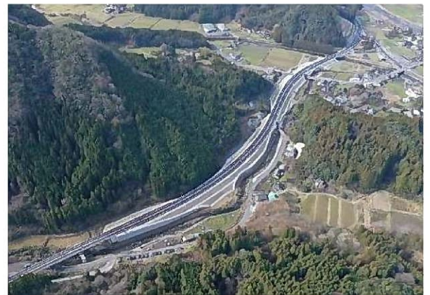
▲ 国道212号 (中津日田道路 耶馬溪道路) 中津市耶馬溪町山移～大島
