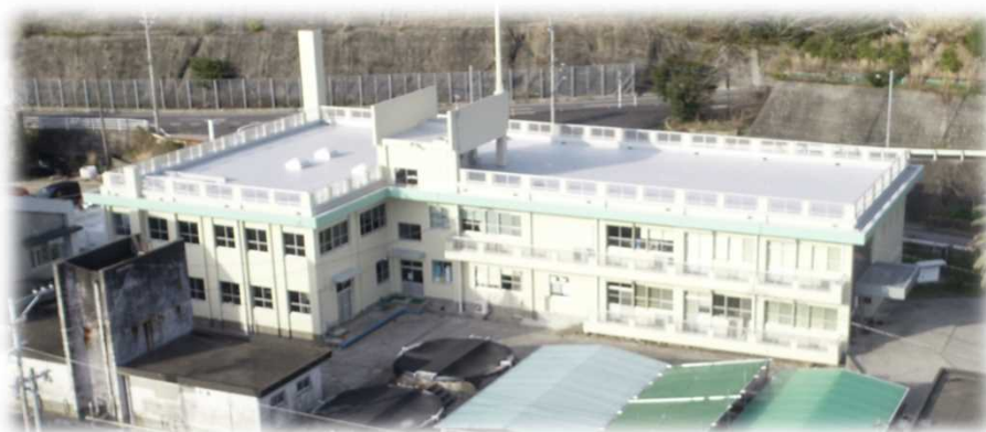
水産研究部(上浦)本館 外壁改修工事完了(令和3年2月25日)
