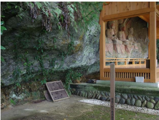
覆屋左側の状況
