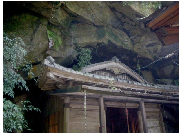
覆屋上方の状況
