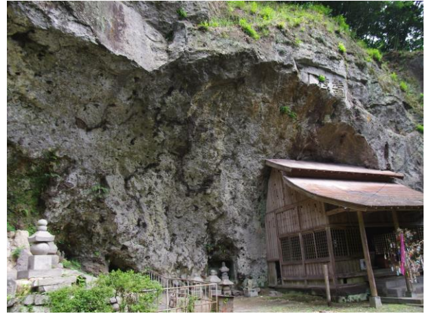
覆屋周辺の状況
