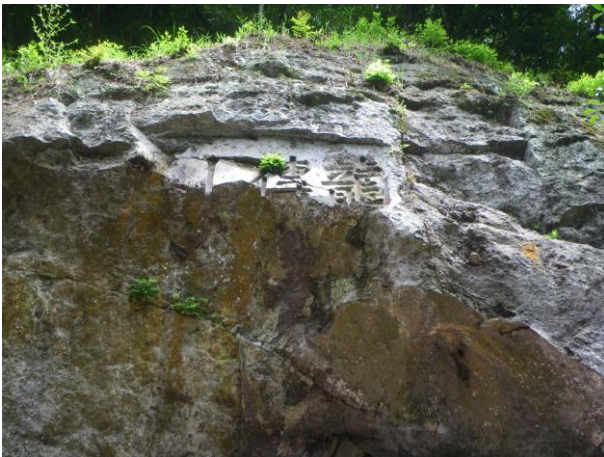
覆屋上方の状況
