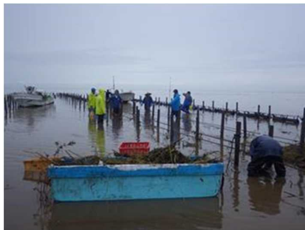
写真2 復旧作業の様子
