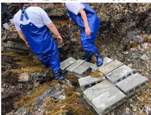
写真3 ブロック設置の様子
