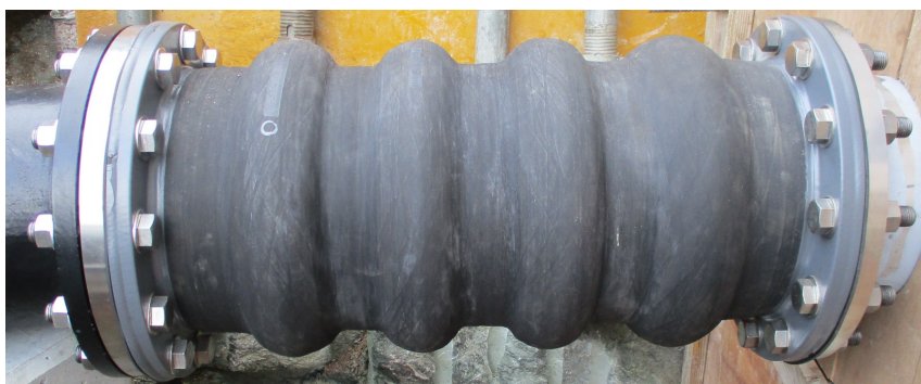
復旧状況写真
