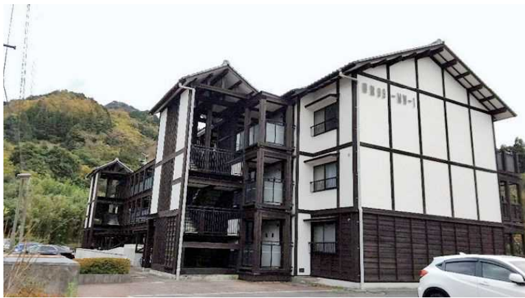
木造3階建公営住宅（県営・津久見市）
