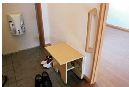
新築時の住戸内（玄関）のバリアフリー
