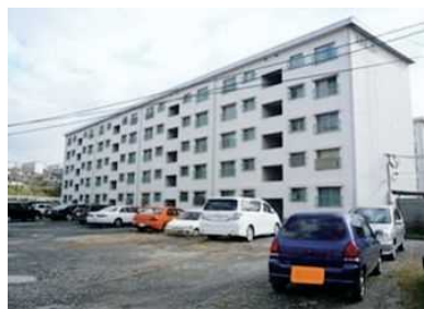
エレベーターのない階段室型住棟
