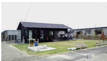
応急仮設住宅敷地内の“みんなの家”（熊本県）
