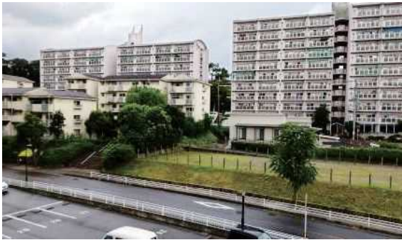
変化のある住棟の配置（県営・大分市）
