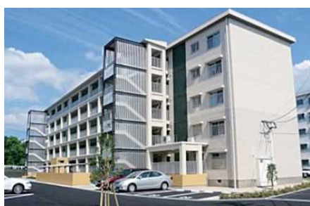
トータルリモデルでの 共用廊下とエレベーターの設置
