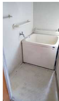
増築時に設置された浴槽
