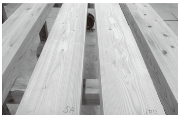
写真-4 仕上げ後の材面の様子
