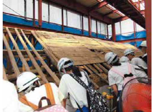
文化財の修復現場公開（草野家住宅）
