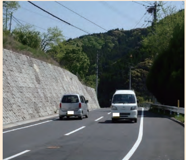
三重弥生線波寄2工区現道拡幅事業（佐伯市）
