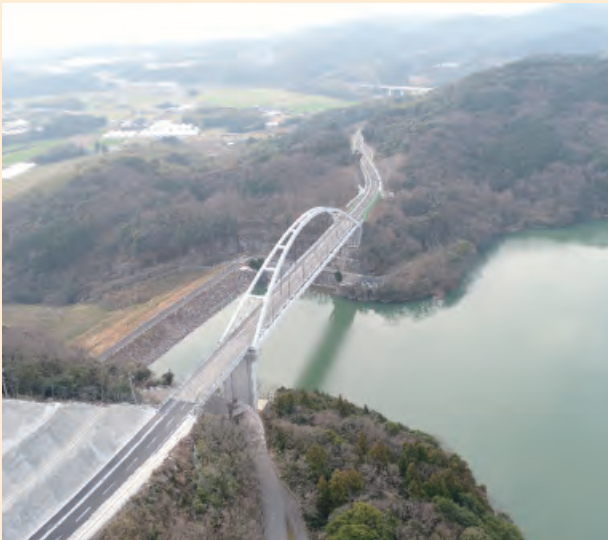
大田杵築線溝井工区バイパス整備事業（杵築市）
