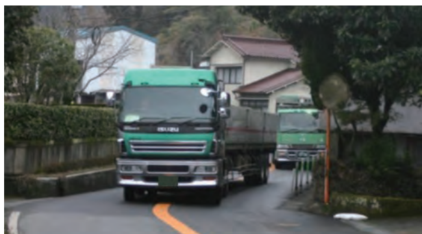
幅員狭小な未改良区間（国道212号 日田市）
