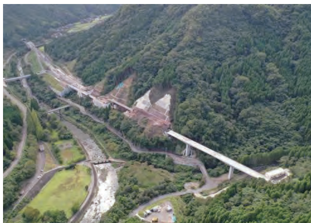
（耶馬溪道路 山移工区）
