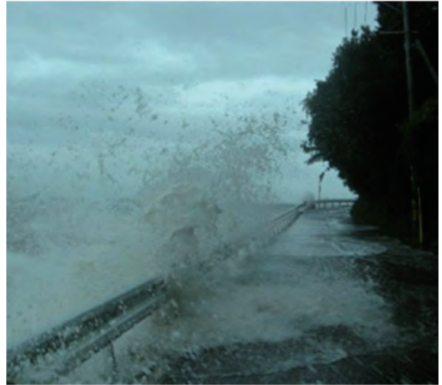
越波による交通障害
