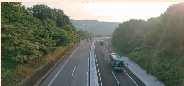
4車線区間を延伸した大分空港道路
