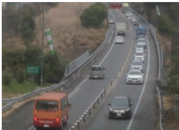
暫定2車線の東九州自動車道（宮河内～臼杵間）
